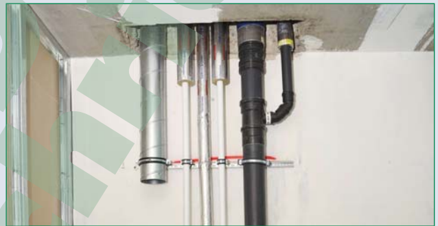
Bild 3: Mit diesem Komplettssystem ist jetzt auch das Stecken von Keller- und Steigleitungen möglich
