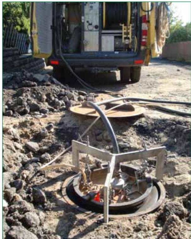
Bild 7: Unterdruckprüfung an Tegra 1000-Schacht
