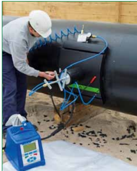
Bild 1: Der korrekte Sitz des Fittings wird am Manometer angezeigt: Vakuum steht – Schweißung starten
