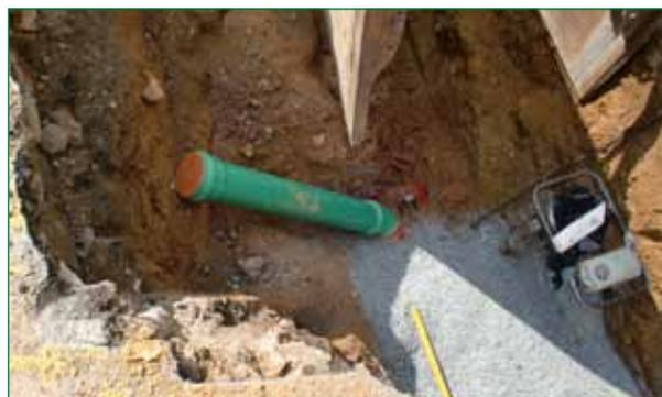
Bild 3: Hausanschlusskanal aus KG 2000-Vollwandrohren aus PP
