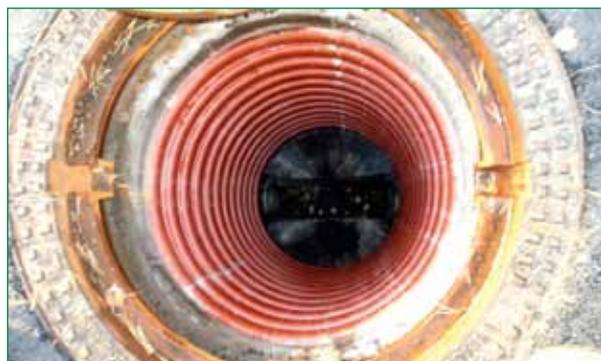
Bild 4: Fertig eingebaut: Tegra 600 Inspektionsschacht aus PP
