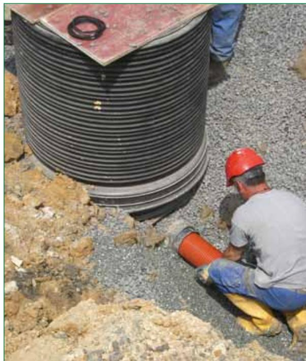
Bild 6: Anschluss des Ultra Rib 2 Kanalrohres an das Kugelgelenk des Tegra 1000 Schachtes
