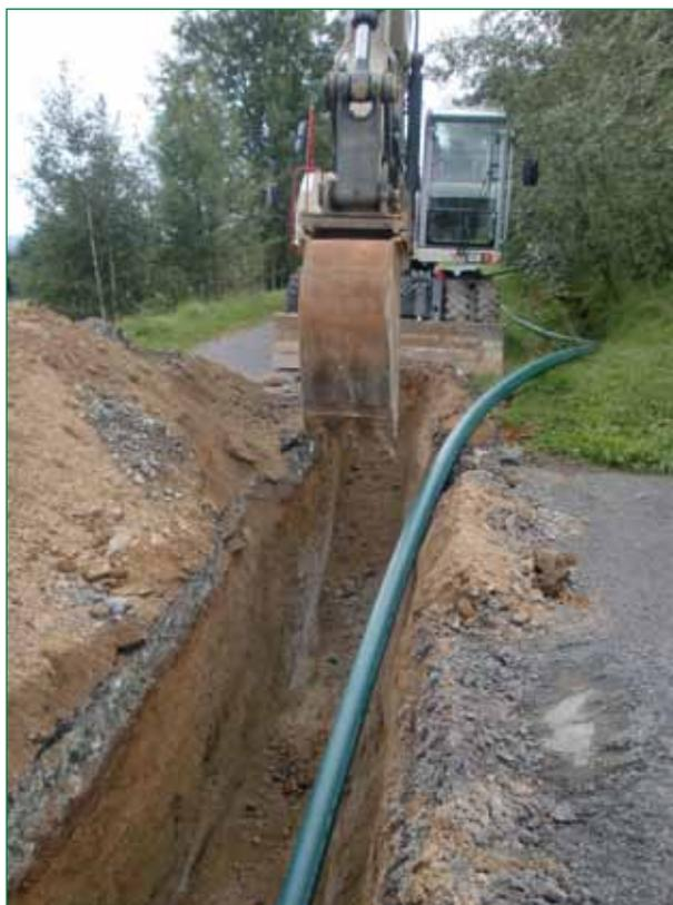
Bild 1: Verlegung des PE 100 RC-Druckrohres im offenen Graben
