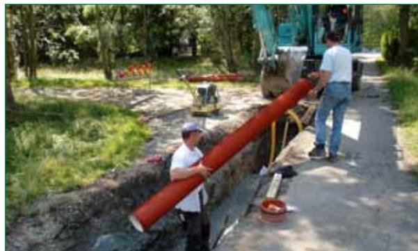
Bild 2: Transport und Bettung der Ultra Rib 2-Kanalrohre aus PP ohne Hebezeuge
