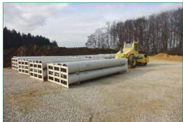
Bild 1: 20.000 lfdm GFK-Trinkwasser-Rohre in den Nennweiten DN 400 und DN 500 in Druckstufen von PN 10 bis PN 25 inklusive der Formteile wurden verlegt
