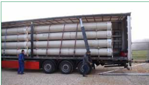
Bild 2: Nach terminlicher Absprache mit der Bauleitung wurden die Wickelrohre von Mochau zur Einbaustelle transportiert (Foto: ZV Laber-Naab)
