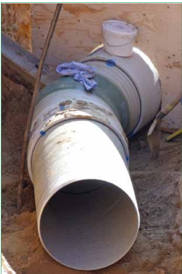
Bild 3: Ein weiterer Vorteil der GFK-Rohre: Ein Bogen kann in nahezu jeder gewünschten Gradzahl hergestellt werden (Foto: ZV Laber-Naab)
