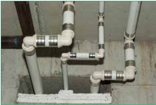
Bilder 2 und 3: Trinkwasserinstallation mit einem Mehrschichtverbundrohrsystem
