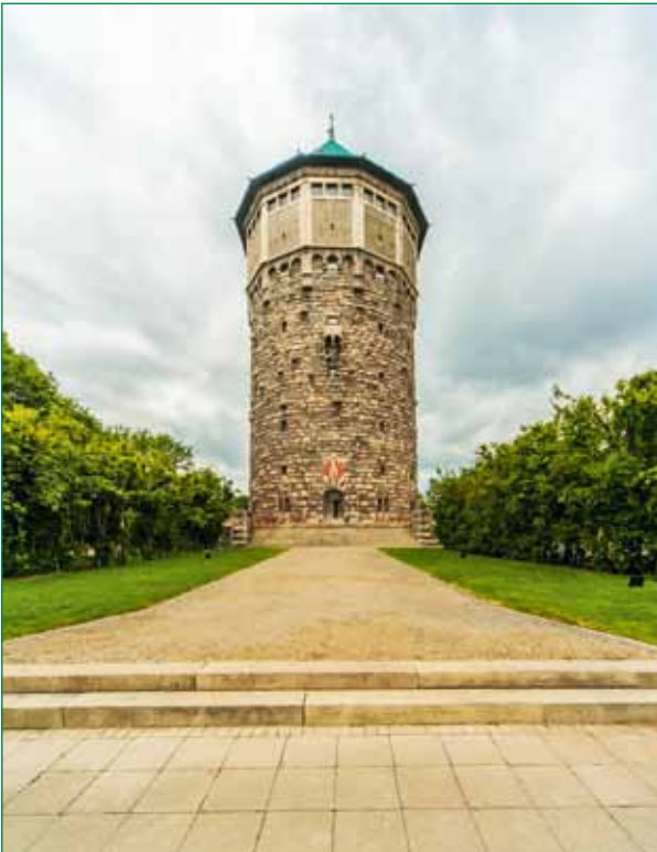
Bild 1: Der Wasserturm in Hannover, das ehemals größte Wasserspeichergebäude in Europa
