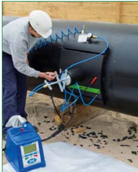
Bild 1: Der korrekte Sitz des Fittings wird am Manometer angezeigt: Vakuum steht – Schweißung starten
