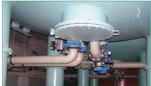
Bild 3: Auslauf- und Regenerierleitung
