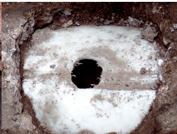
Bild 8: Freigelegtes Compact Pipe nach dem Auffräsen
