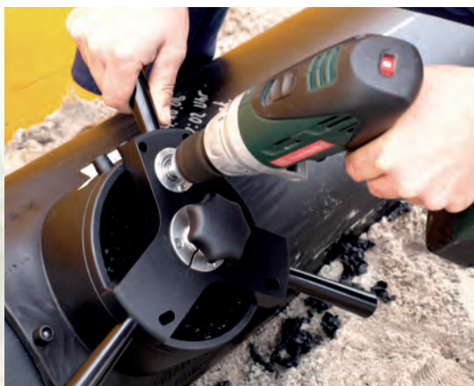
Bild 4: Anbohrvorgang mit FWFIT
