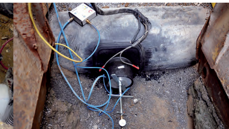
Bild 10: Mit VACUSET XL aufgespannter Abwassersattel ASA-VL
