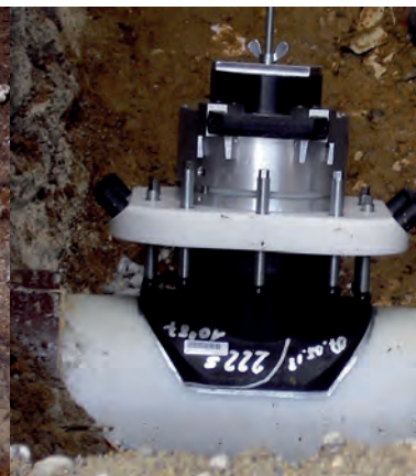
Bild 9: ASA-TL/KG aufgespannt mit ASATOP
