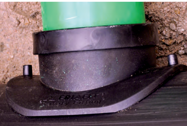
Bild 7: Übergangssattel ASA-TL/KG
