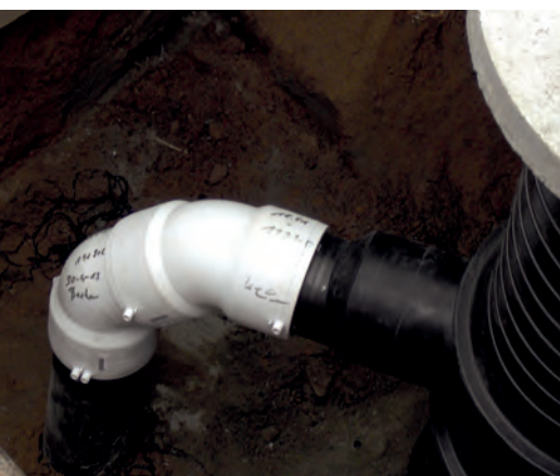
Bild 1: Materialhomogener Anschluss eines Straßeneinlaufes
