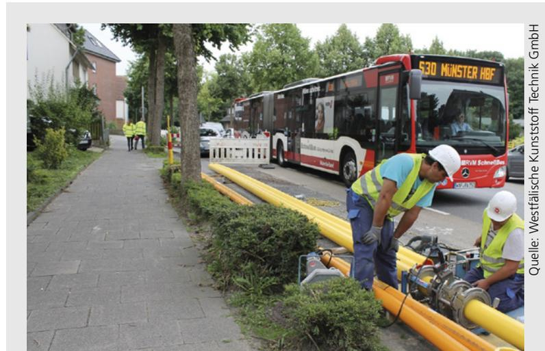
**Bild 1:** Installation einer Gasleitung im innerstädtischen Bereich
