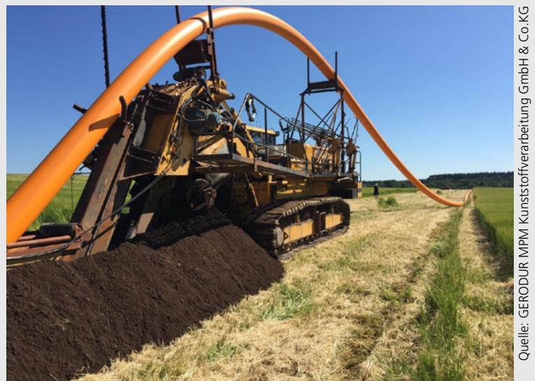
**Bild 2:** Umwelt- und ressourcenschneller Einbau von Gasrohren im Rohrflugverfahren
