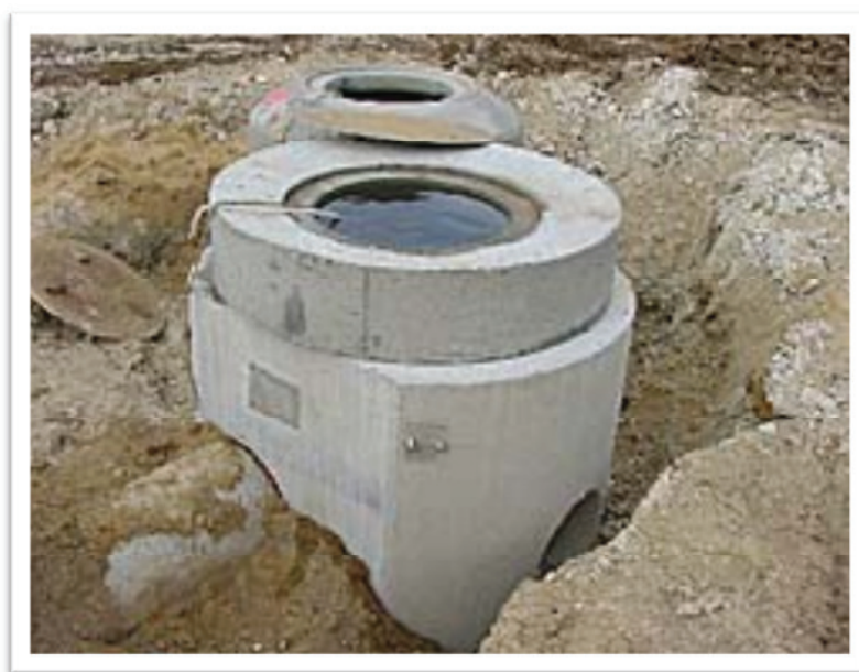
Abbildung 9-E: Prüfung Betonschacht auf der Baustelle
