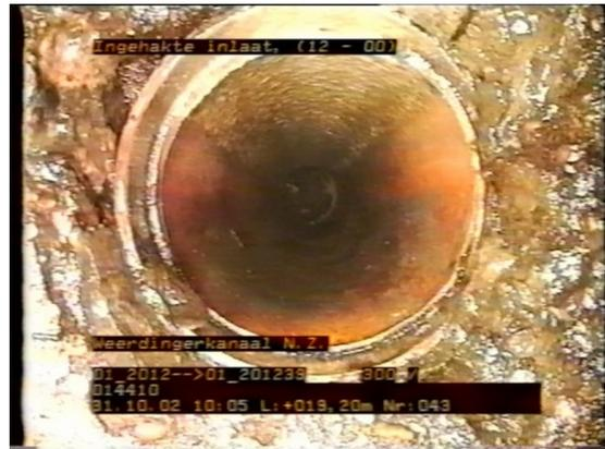
Abbildung 15: NL BBF (Infiltration) S&P: zusätzlich BAH (schadhafte Verbindung)
