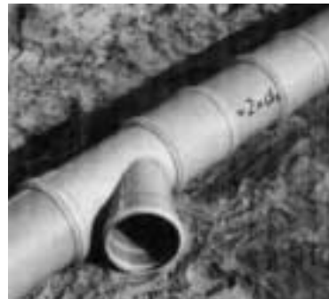
Bild 14: Nachträglicher Einbau eines Abzweiges
