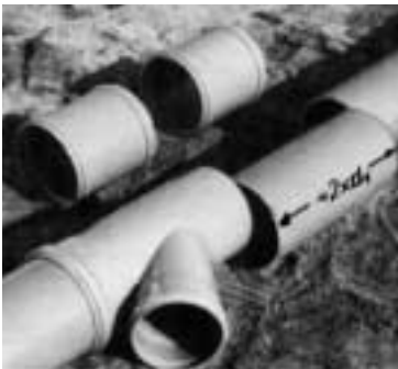
Bild 14: Nachträglicher Einbau eines Abzweiges
