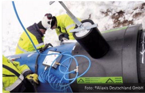
Bild 16: Arbeiten bei niedrigen Temperaturen
