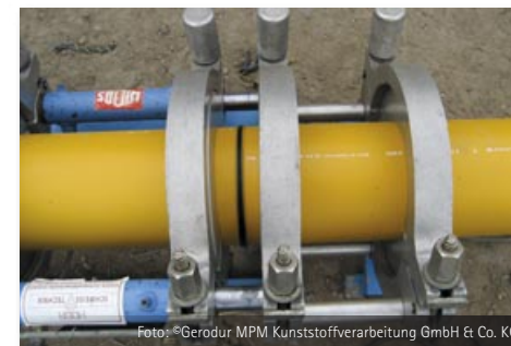
Bild 27: Heizelement-Stumpfschweißen
