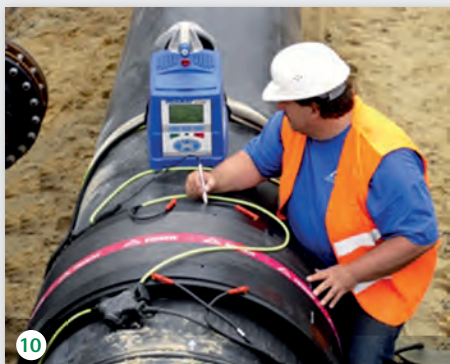
Bild 10: Heizwendel-Schweißverfahren: Einlesen des Barcodes einer PE-Schweißmuffe d 900
