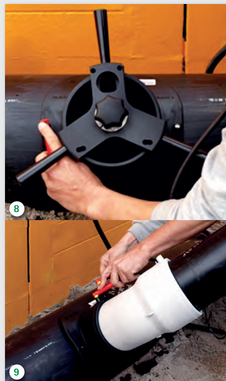
Bild 8 und 9: Herstellen eines Hausanschluss-Schweißsattels für eine Anschlussleitung d 160
