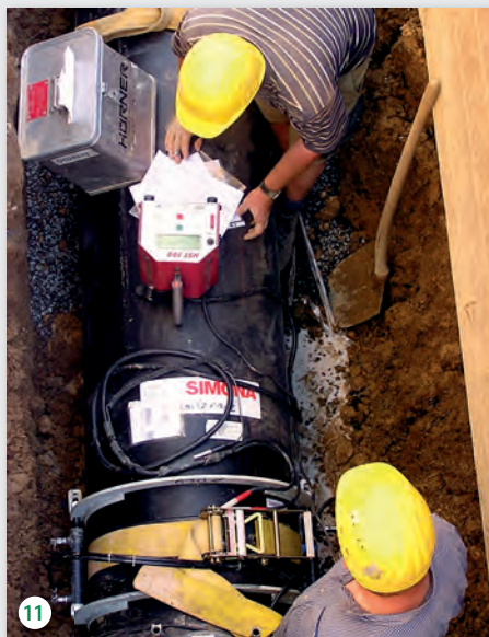
Bild 11–13: Heizwendel-Schweißverfahren: wandintegrierte Heizwendel
