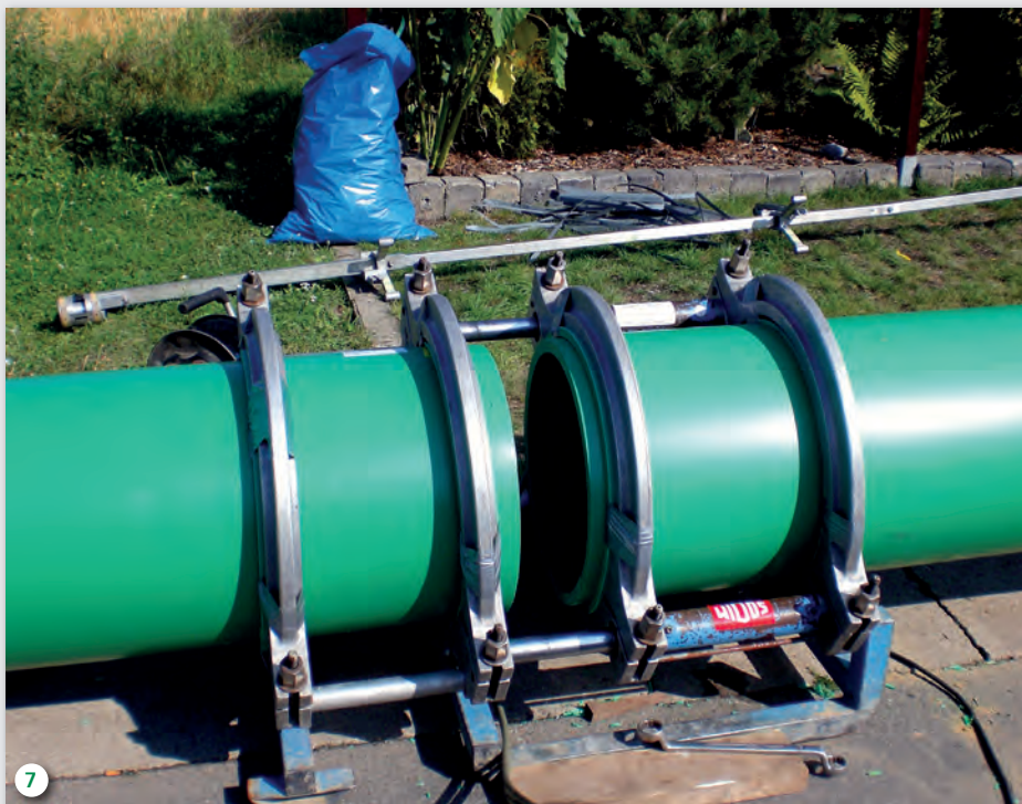
Bild 7: Heizelement-Stumpfschweißverfahren
