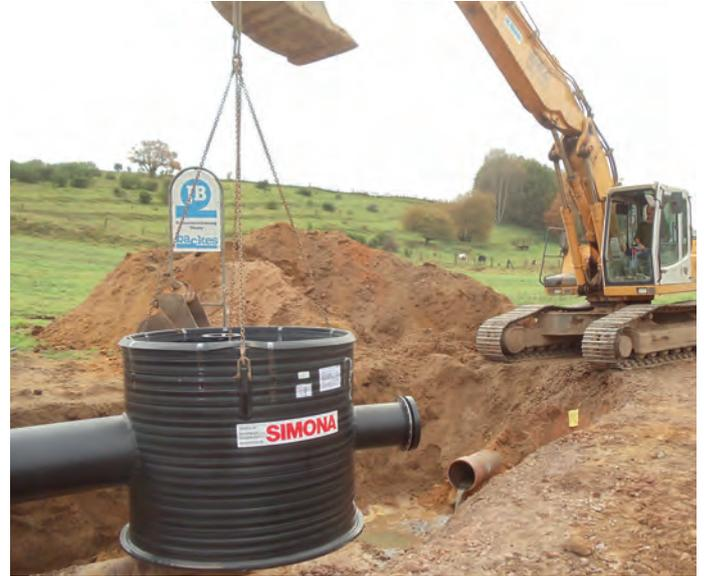
Doppelwandiges PE-Rohrsystem mit exakt eingemessenen Hausanschlüssen, Quelle: SIMONA AG
