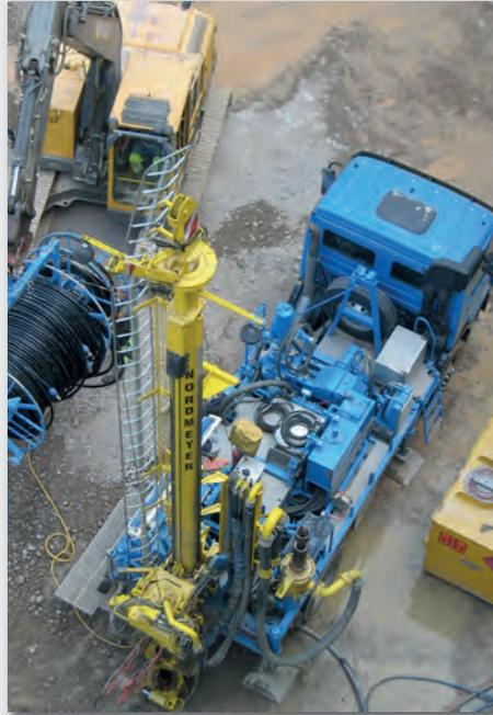
Bohrgerät und Erdwärmesonde auf
