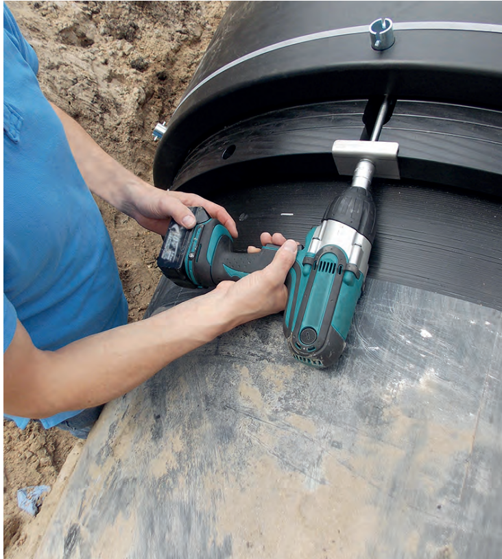
Bild 5: Keilaktivierung mittels Akku-Schrauber
