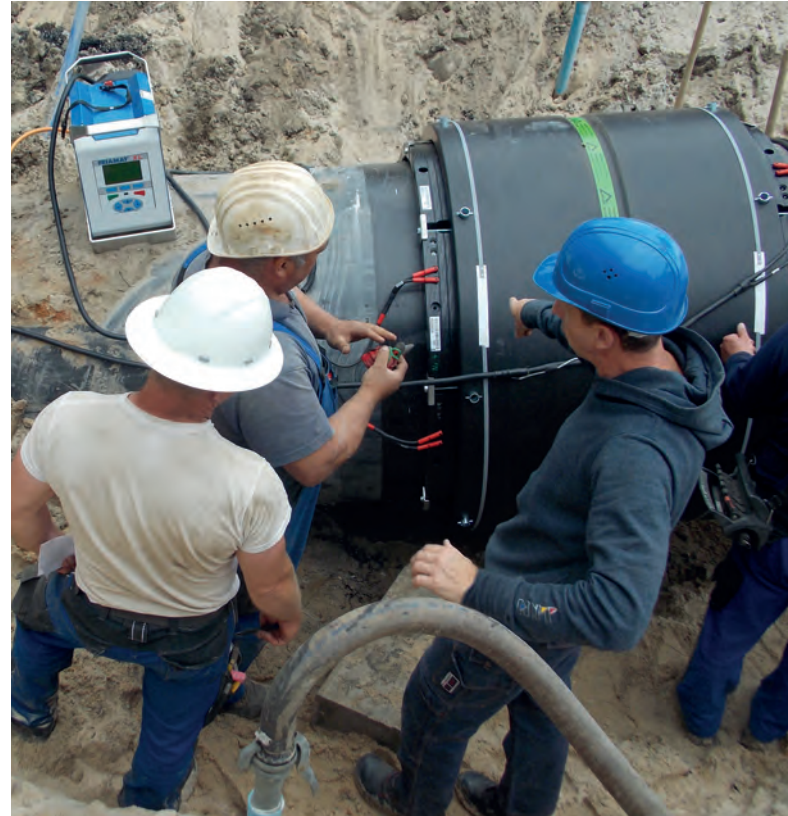
Bild 6: Die Schweißung kann durch den Einsatz von zwei Schweißgeräten, FRIAMAT XL, optimiert werden.
