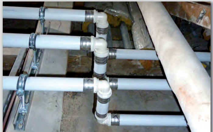
Bild 4: Die praktische Leckage-Funktion der alpex-Installationssysteme von FRÄNKISCHE zeigt bei der Druckprüfung unverpresste Stellen an.
