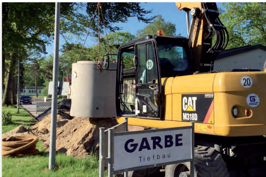
Bild 2+3: Die Paul Garbe Tiefbau GmbH im Einsatz. Absetzen eines Betonfertigteil-schachtes mit bereits integriertem PE-Schachtanschluss in den Verbau und Ausrichten des Schachtkörpers
