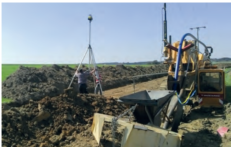
Bild 4+5: PE Rohrstrang wird in dem ausgefrästen Rohrgraben sandbettfrei platziert
