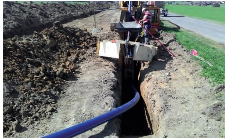
Bild 3: PE Rohrstrang wird in dem ausgefrästen Rohrgraben sandbettfrei platziert
