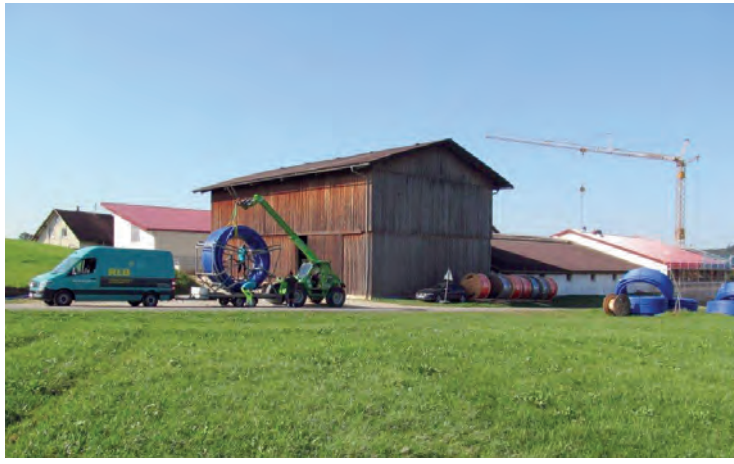
Bild 2: Anlieferung und Installation, Ringbunde zur Installation mittels Spülbohrverfahren
