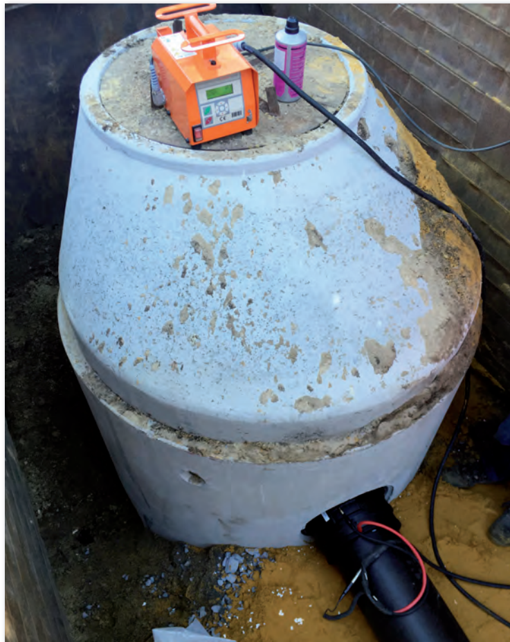
Bild 4+5: Verschweißte Verbindungen, Schachtanschluss-System (links) und Elektroschweißsattel (rechts) aus dem PLASSON LightFit Abwasserprogramm
