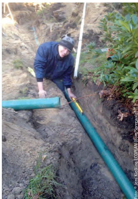
Bild 6: Ein großes, altes Forsthaus mit drei Abwasser-Abgängen sowie drei weitere Gebäude, die auf dem weitläufigen Spreewald-Gelände verteilt waren, mussten mit der Pflanzen-Kläranlage verbunden werden
