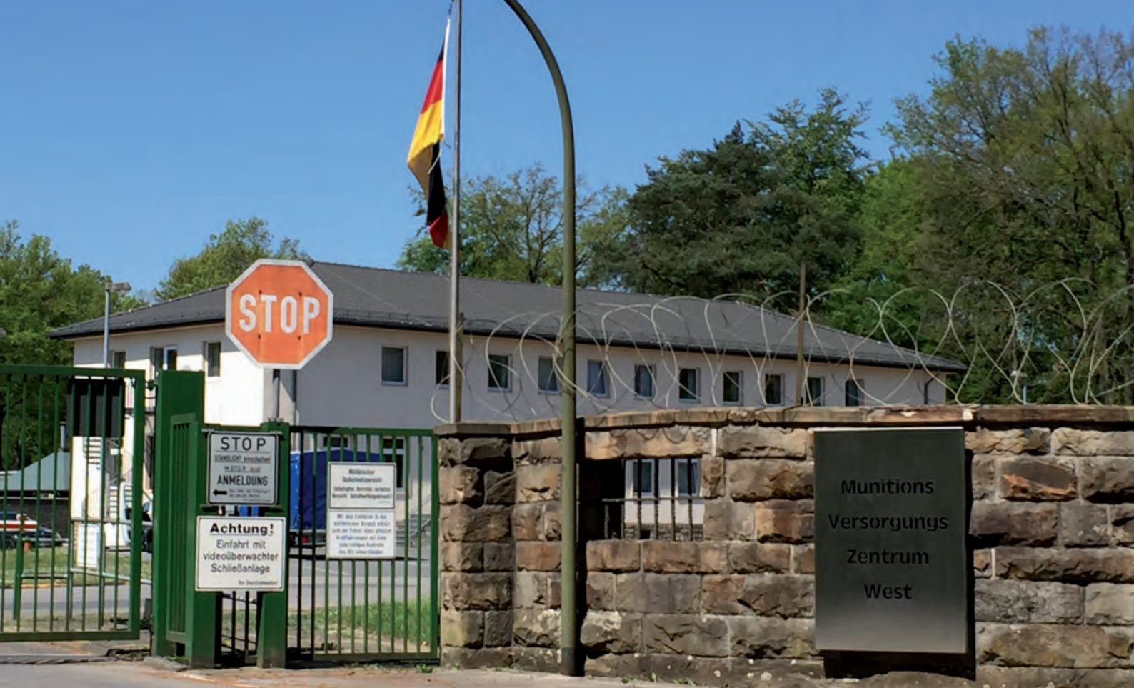
Bild 1: Munitionsversorgungszentrum (MunVersZ) West in Dorsten
