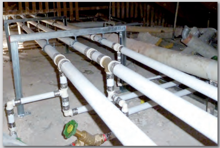
Bild 4: Die praktische Leckage-Funktion der alpex-Installationssysteme von FRÄNKISCHE zeigt bei der Druckprüfung unverpresste Stellen an.
