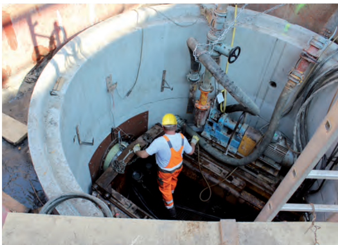
Bild 4: Beim Vortrieb wurde ein Microtunneling-Verfahren mit flüssigkeitsgestützter Ortsbrust und Spülförderung eingesetzt.
