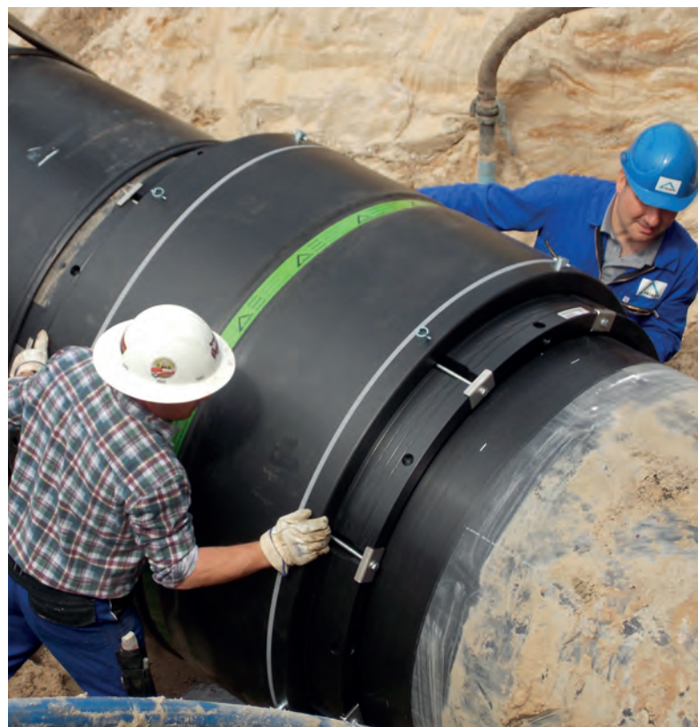
Bild 4: Keilmuffe KM XL lässt sich kinderleicht überschieben.
