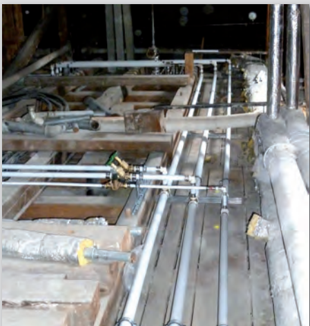
Bild 5: In 66 Gästezimmern im Altbau des Hotels Badischer Hof ist nach der Renovierung das alpex-System von FRÄNKISCHE die Grundlage für die Heizungs- und Sanitärinstallation.
