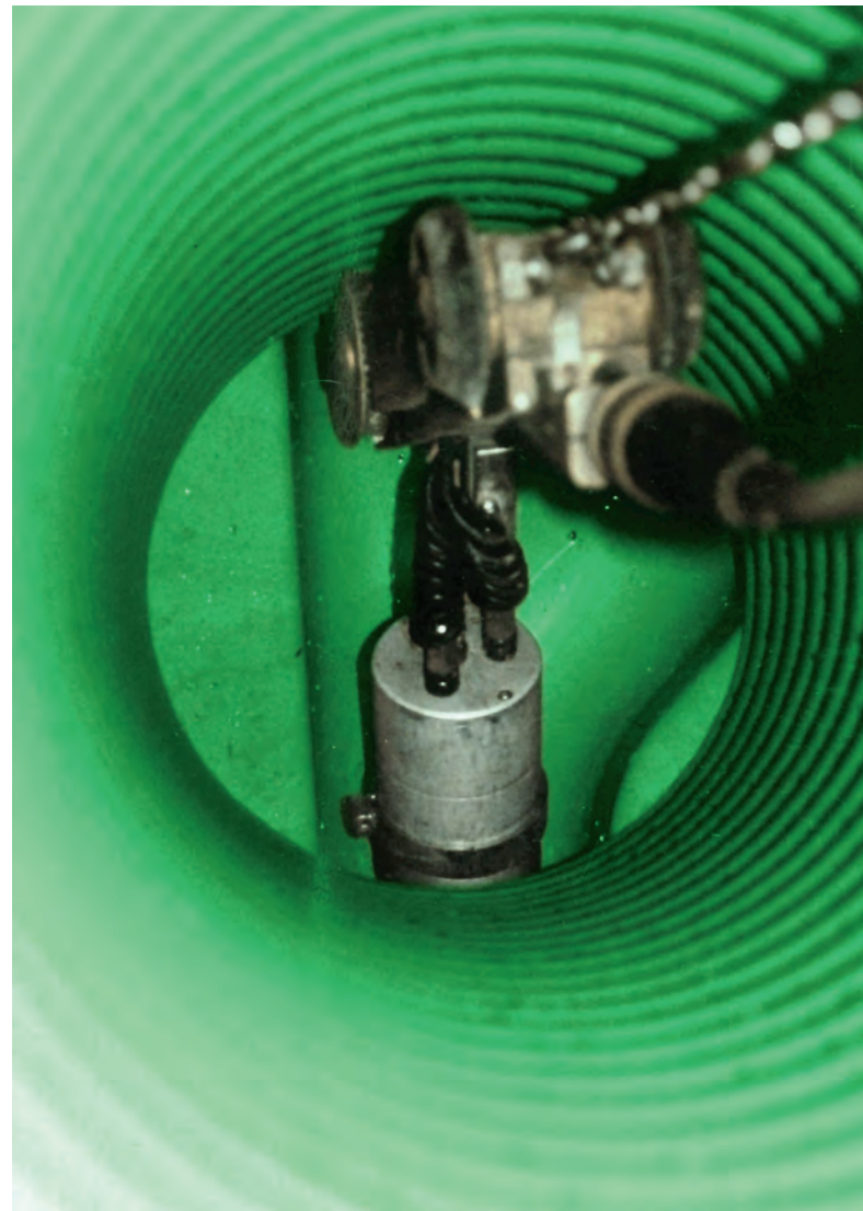
Bild 5: Inspektionsschacht DN 315, Kameraeinführung
