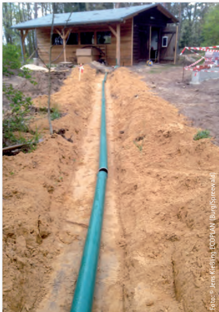
Bild 7: Eine Besonderheit lag bei der speziellen Einbettung der Rohre als Freispiegelleitungen mit sehr geringer Bodenüberdeckung im natürlichen Gefälle
