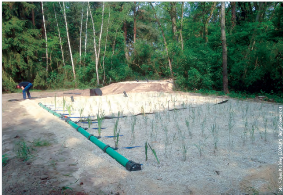
Bild 8: Das mehr als 300 Meter lange, besonders umweltfreundliche Abwasserrohrsystem „GreenTube“ von Omniplast endet schließlich in einer naturnahen Pflanzenkläranlage, bei der aktuellste Erkenntnisse aus 25 Jahren Praxiserfahrung des Planers Anwendung finden. Im Hintergrund ist ein zusätzliches Pflanzenbeet mit integrierter Klärschlammkompostierung zu sehen.
