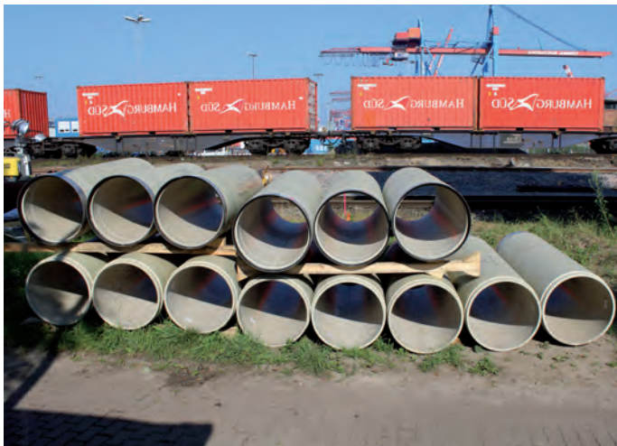
Bild 3: Die EBA-Zulassung schuf die Voraussetzung für die Verwendung der Flowtite GFK-Vortriebsrohre im Hamburger Hafen
