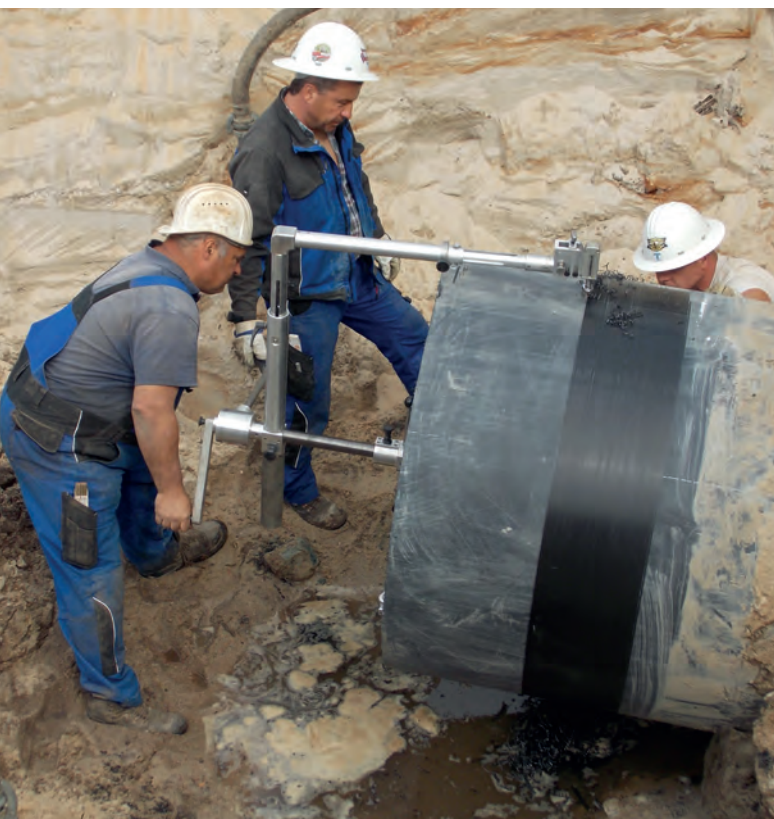
Bild 3: Schälgerät FWSG XL im Einsatz
