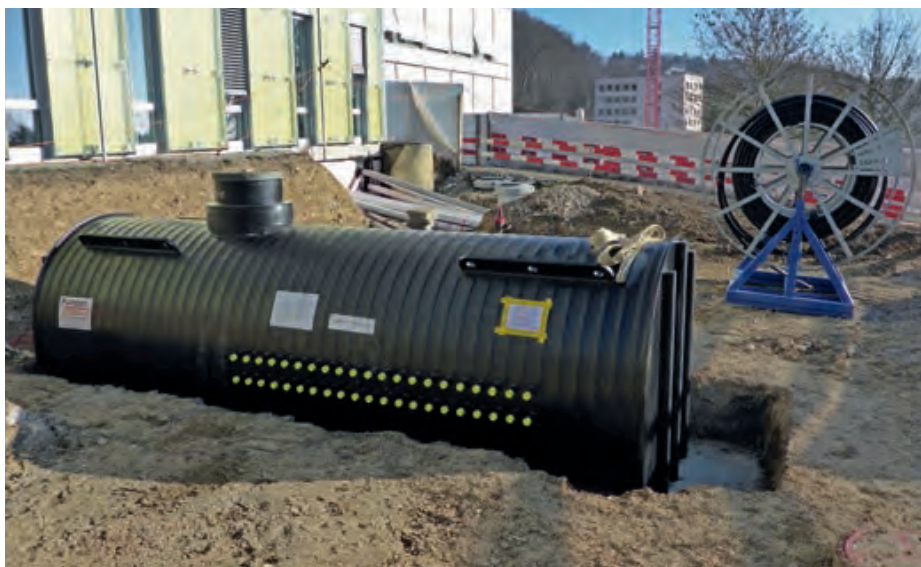
Bild 6: Erdverlegte Kunststoffschächte mit eingebauten Vor- und Rücklaufverteilern aus Kunststoff, speziell maßgefertigt für diese Anlage
