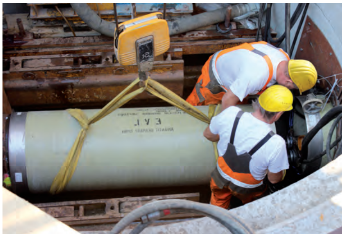
Bild 1: Für die Unterfahrung des Bahndamms kamen GFK-Vortriebsrohre DN 650 zum Einsatz, die mit einer Edelstahl-Kupplung ausgerüstet sind.
