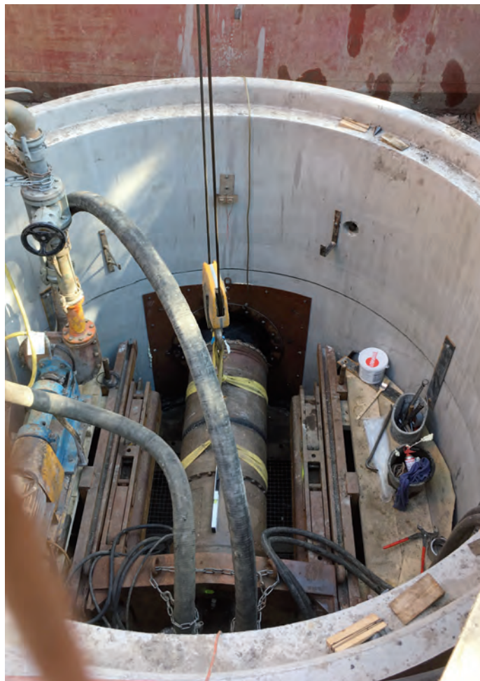
Bild 2: In Vorbereitung auf die Vortriebsarbeiten wurden beidseitig des Bahndamms Absenkschächte als Start- und Zielgrube abgetäuft.
