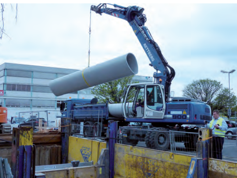
Bild 3+4: Einbringen des werkseitig geschweißten 7,5 m Modules in die Baugrube und Anschweißen an den Rohrstrang für den Relining-Einzug.
