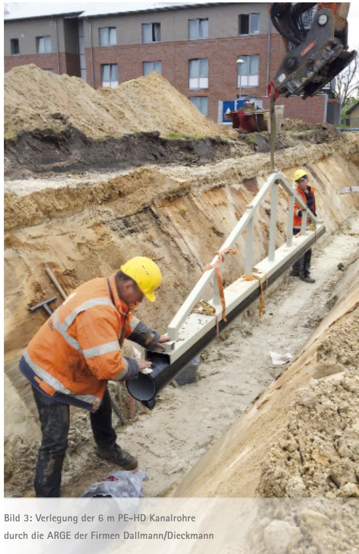
Bild 3: Verlegung der 6 m PE-HD Kanalrohre durch die ARGE der Firmen Dallmann/Dieckmann
