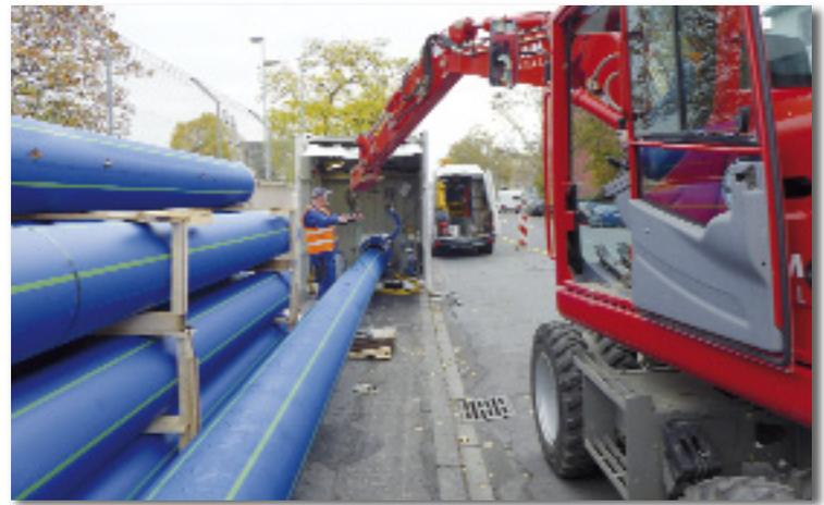
Bild 8: Rohrtransport zum Schweißen
