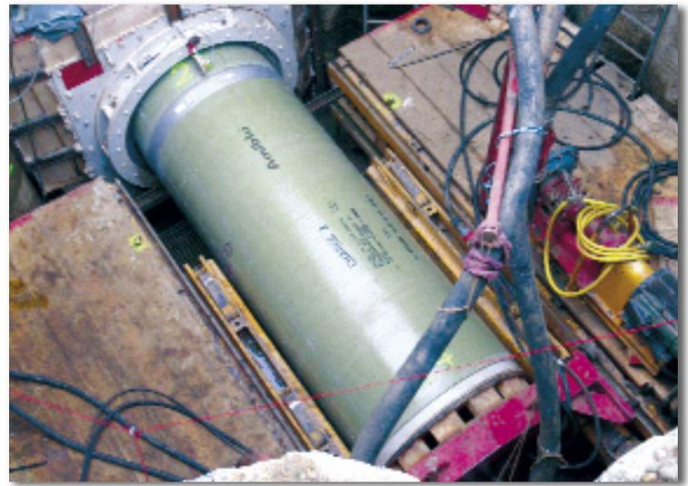
Bild 3: Vortrieb der GFK-Rohre im Mikrotunnelbauverfahren.
