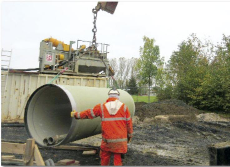
Bild 2: Das geringe Gewicht der Rohre erleichtert das Handling auf der Baustelle.
