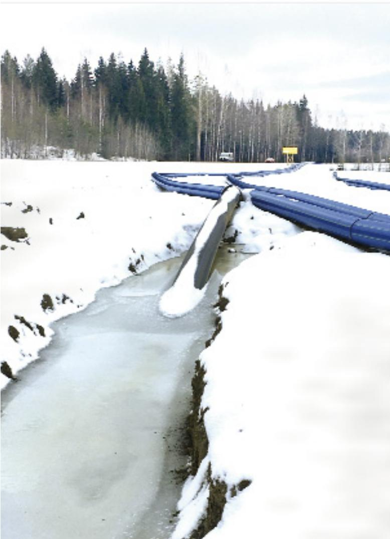
Wasserwerke Kymenlaakson Vesi investierten daher 10 Mio. Euro in den Bau einer zweiten Trinkwasserleitung auf einer Strecke von insgesamt 25 Kilometern. Diese wurde auf nahezu der gesamten Trasse als PE-Rohr, OD 560 mm in SDR 17 ausgelegt.
