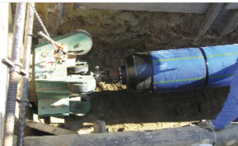
Bild 4: Zugkopf und Zentriereinheit
