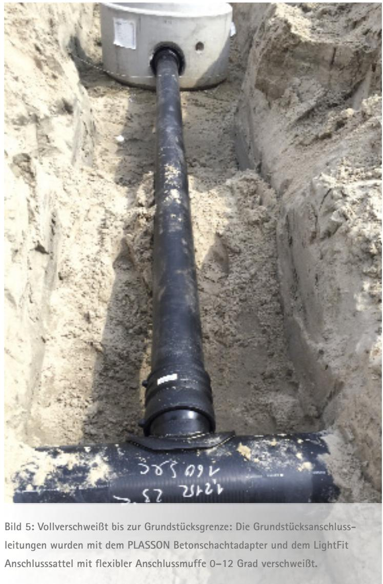
Bild 5: Vollverschweißt bis zur Grundstücksgrenze: Die Grundstücksanschlussleitungen wurden mit dem PLASSON Betonschachtadapter und dem LightFit Anschlussattel mit flexibler Anschlussmuffe 0–12 Grad verschweißt.
