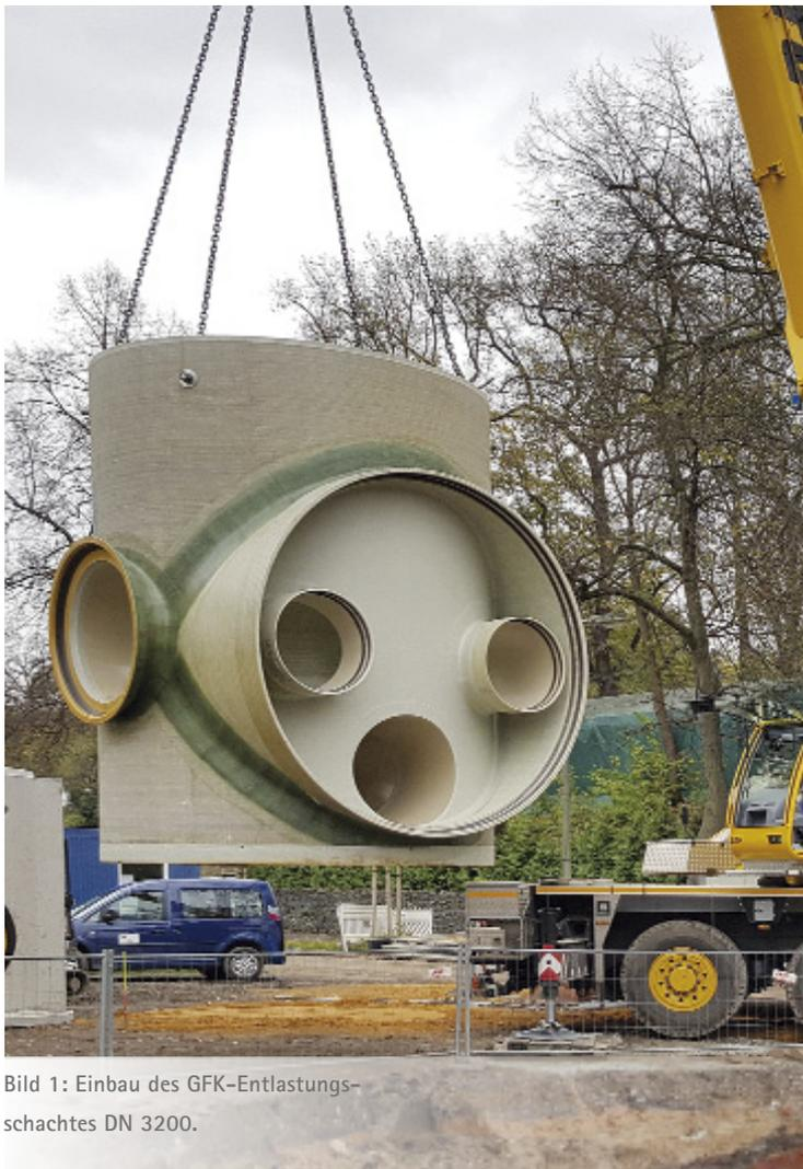
Bild 1: Einbau des GFK-Entlastungs-
