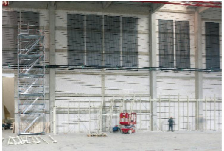
Bild 8: Die im Objekt eingesetzten Registerelemente wurden bereits im Hauptwerk der Unternehmensgruppe aquatherm in Attendorn objektspezifisch produziert. Dies ermöglichte eine schnelle Montage vor Ort.
