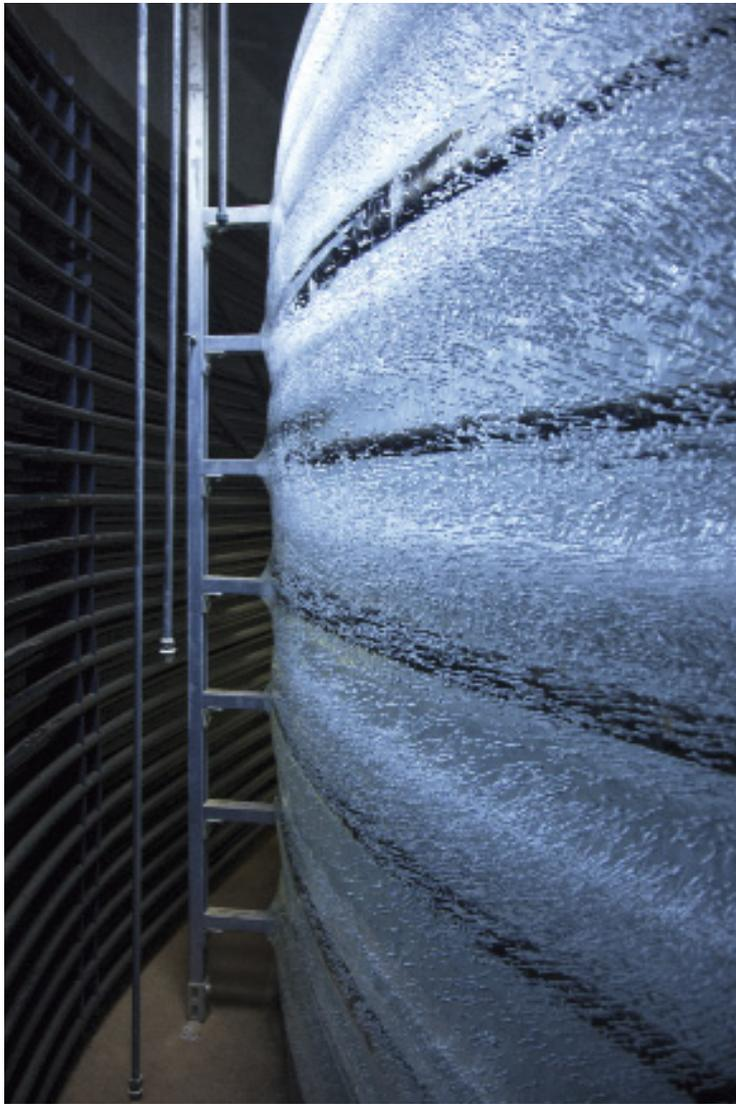
Bild 6: Einer der größten Eis-Energiespeicher Deutschlands bildet das Herzstück des Energiesystems im 2T.
