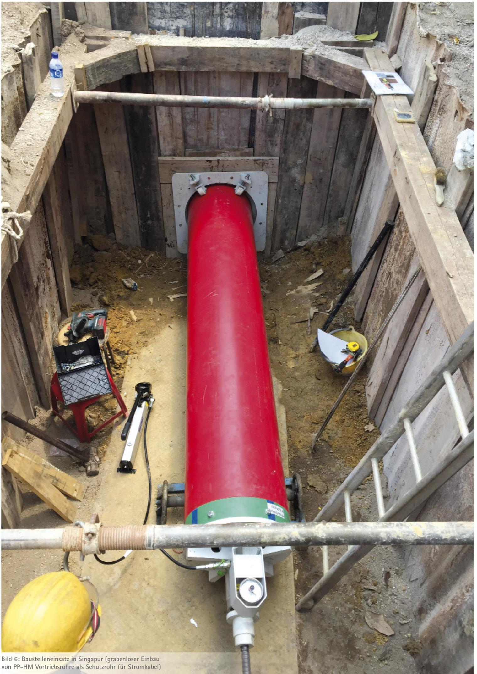
Bild 6: Baustelleneinsatz in Singapur (grabenloser Einbau von PP-HM Vortriebsrohre als Schutzrohr für Stromkabel)
