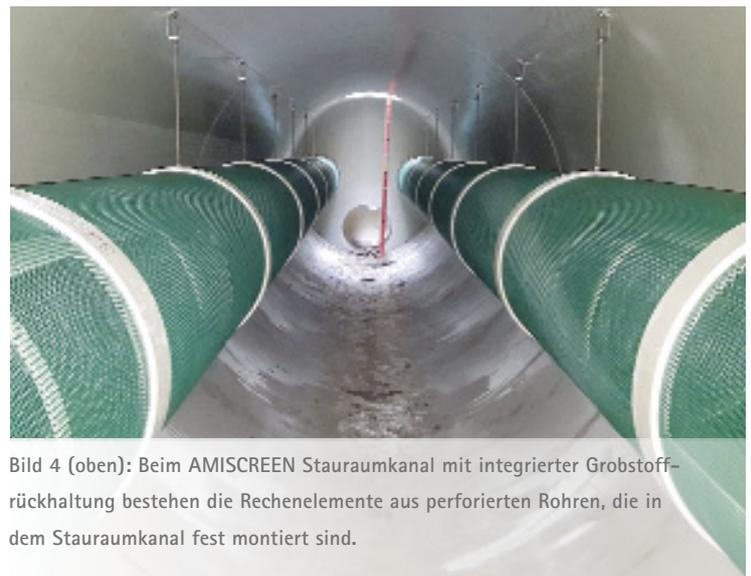
Bild 4 (oben): Beim AMISCREEN Stauraumkanal mit integrierter Grobstoffrückhaltung bestehen die Rechelemente aus perforierten Rohren, die in dem Stauraumkanal fest montiert sind.
