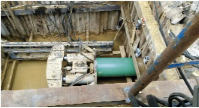
Bild 7: Einbau PP-HM Vortriebsrohr
