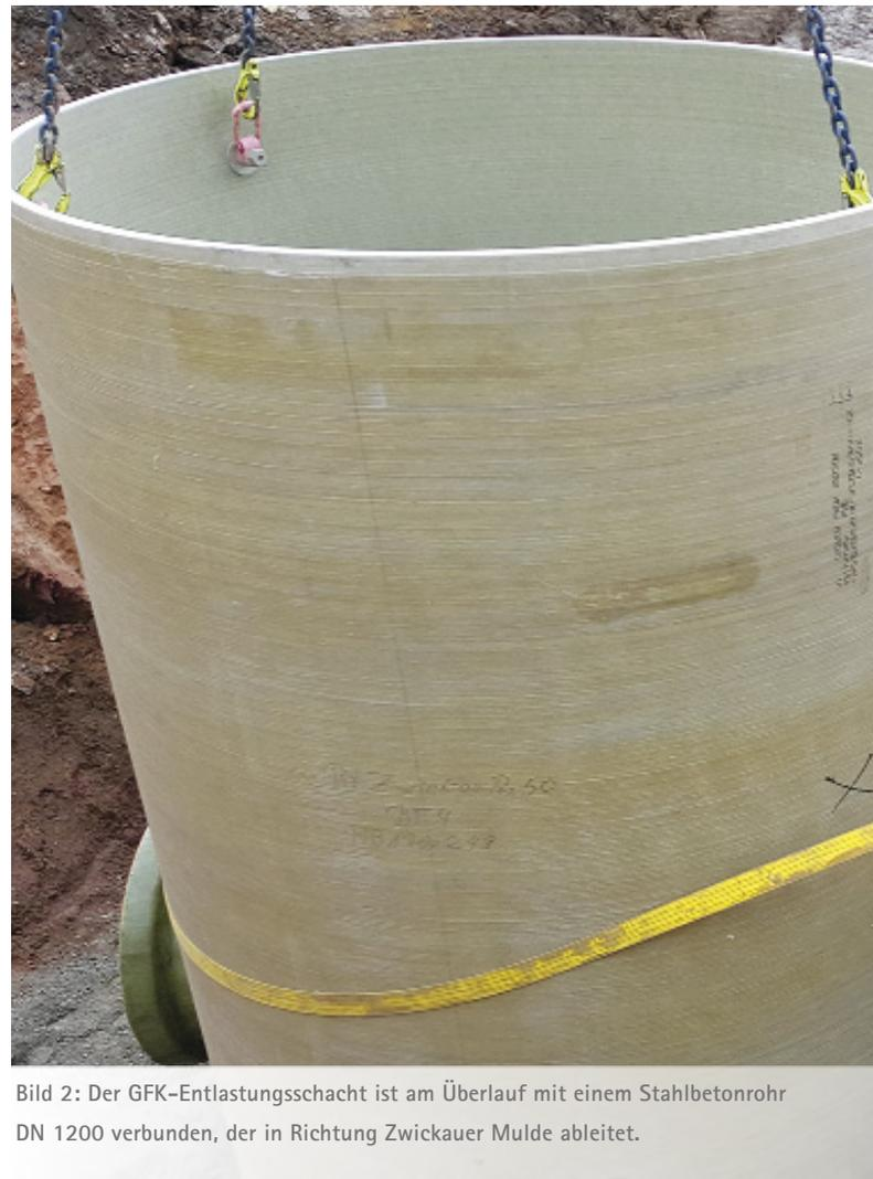
Bild 2: Der GFK-Entlastungsschacht ist am Überlauf mit einem Stahlbetonrohr
