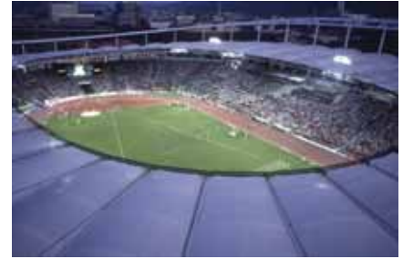
Für höchste Belastungen mit wenig Material: Das Dach des Gottlieb-Daimler-Stadions in Stuttgart.
