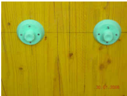
Zeichnen Sie die Hilfslinien an und befestigen Sie den Befestigungsteller mit vier Nägeln.
