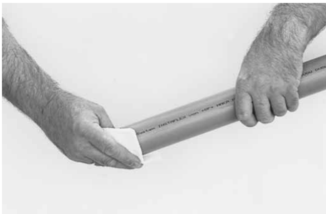
Reinigung des Rohrendes
