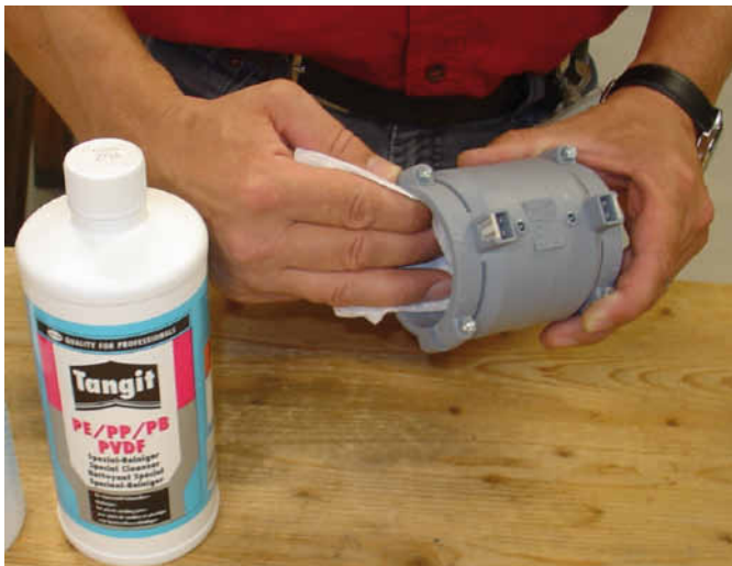
Reinigung des Formteils
