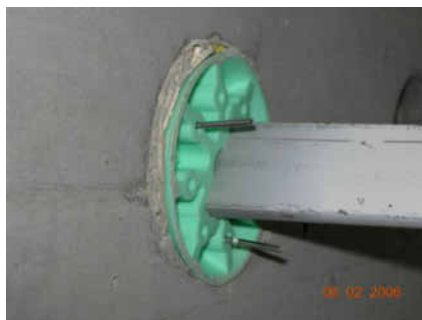
Ausdrehen mit passendem Flacheisen 5 x 25 mm
