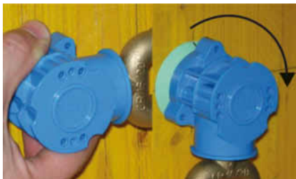
Schrauben Sie den Armaturenanschluss auf den Befestigungsteller.
