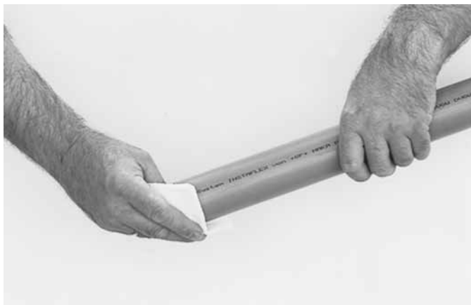
Reinigung des Rohrendes
