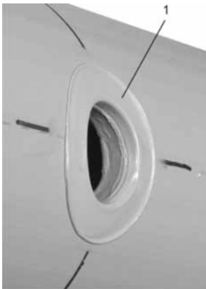
1 Schmelzwulst Nach dem Anwärmen von Rohr und Sattel hat sich am Rohr um die Bohrung eine gleichmässige Schmelzwulst gebildet.
