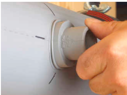
Nach dem Abziehen von den Heizbuchsen drücken Sie sofort den Aufschweiss-Sattel in das Rohr. Achten Sie darauf, den Sattel dabei nicht zu verdrehen. Halte- und Abkühlzeiten siehe Tabelle 1.
