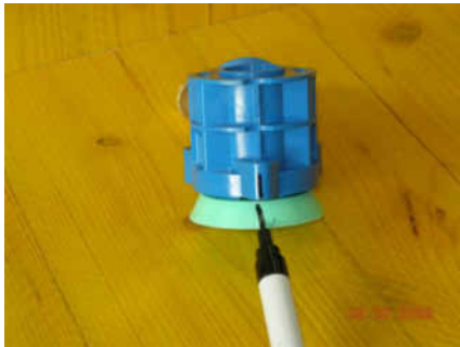
Markieren Sie die eingeschraubte Position am Armaturenanschluss sowie am Befestigungsteller.
