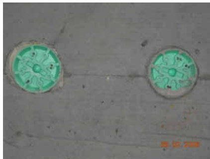
Nach dem Entfernen der Schalung
