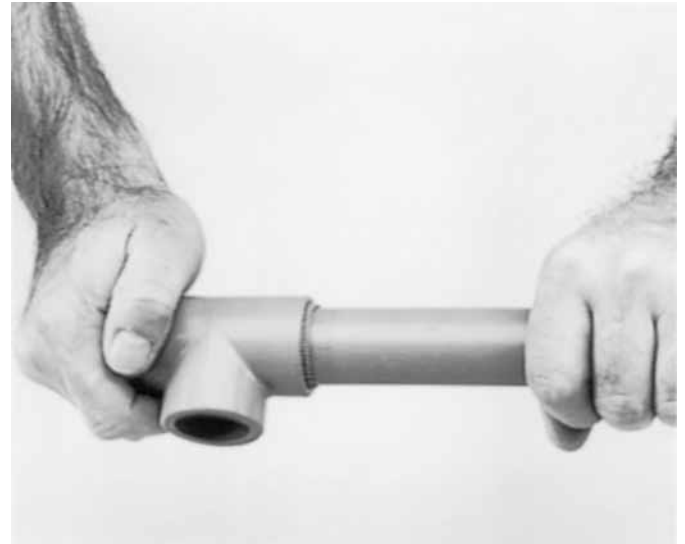
Fügen von Formteil und Rohr
